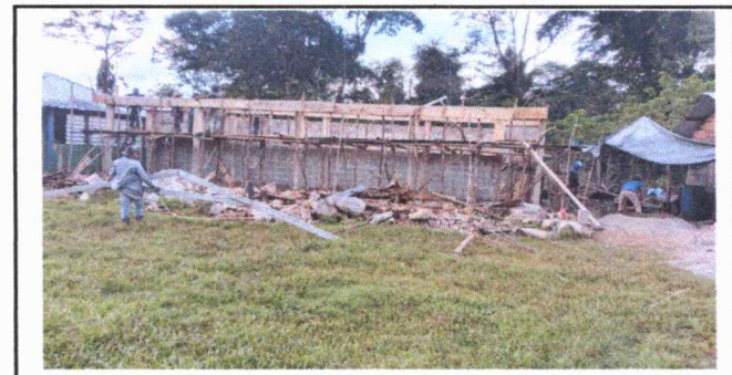
Foto 6: INSTALACION DE SOLERAS Y COLUMNAS DE CONCRETO EN EL CORREDOR
