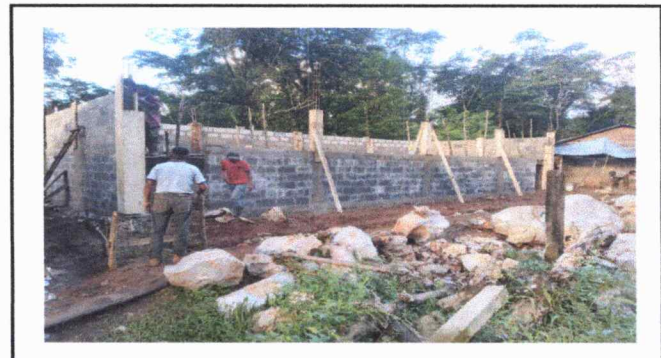
Foto 4: INSTALACION DE BLOCK EN TODO EL AULA
