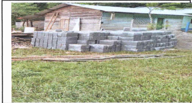
Foto1: INGRESO DE BLOCK PARA SUSTITUCION DE PAREDES.
