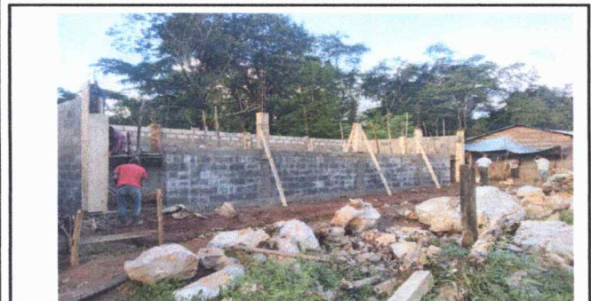
Foto 5: INSTALACION DE COLUMNAS DE CONCRETO PARA VENTANAS
